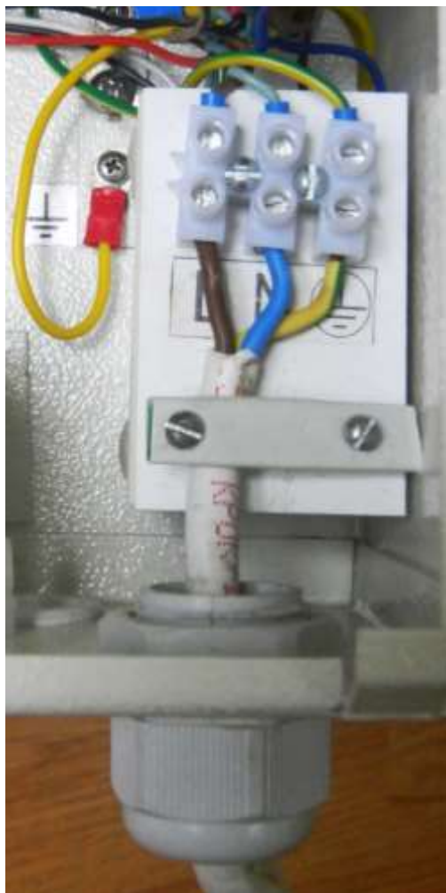
Рисунок 3 – Подключение питающей сети
