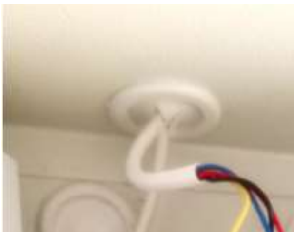
Рисунок 4 - Ввод проводов для подключения.
