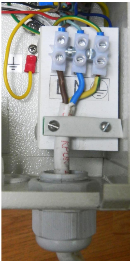
Малюнок 3 - Підключення мережі живлення
