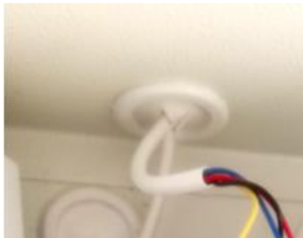
Малюнок 4 - Введення проводів для підключення.
